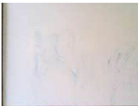
Kurz nach Auftragen des Reinigers beginnt sich das Graffiti zu lösen
