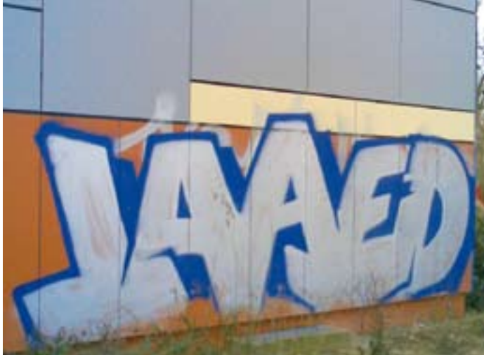
Wohnhaus, Frankfurt am Main: Graffiti-Entfernung und Farb- reparatur mit Farbtonmessung
